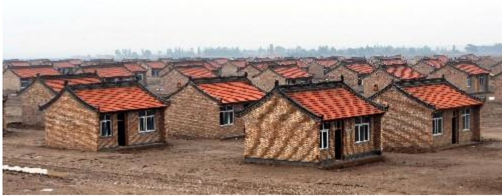
寧夏自治区固原市原州区にある建設中の移民村（9月7日撮影）
